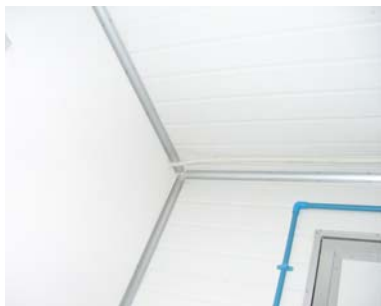
ภาพที่ 27 ติดตั้งสายไฟในท่อติดกับผนังและปลั๊กไฟที่ป้องกันอันตรายจากกระแสไฟฟ้า
