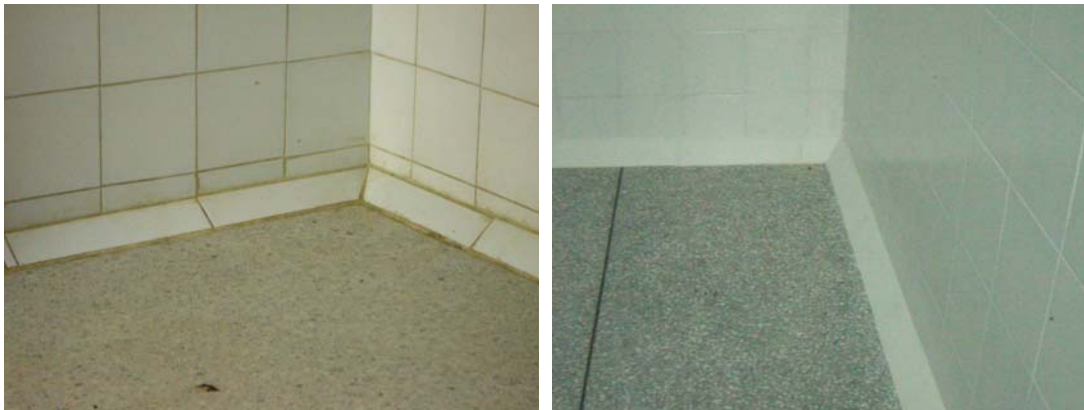
ภาพที่ 7 พื้นห้องของโรงพยาบาลที่มีรอยเชื่อมระหว่างพื้นกับผนังเชื่อมสนิทกัน
