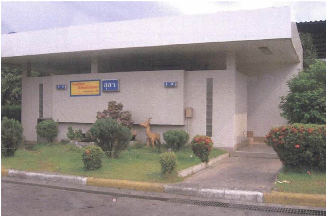
ห้องน้ำที่สร้างอยู่ภายนอกอาคาร
