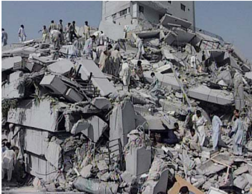
อาคารถล่มหลังเกิดแผ่นดินไหว
