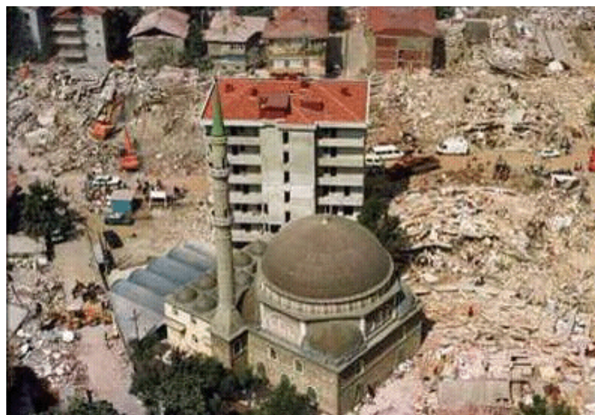
อาคารที่มีโครงสร้างไม่แข็งแรงเมื่อเกิดแผ่นดินไหวจะเกิดอาคารถล่ม
