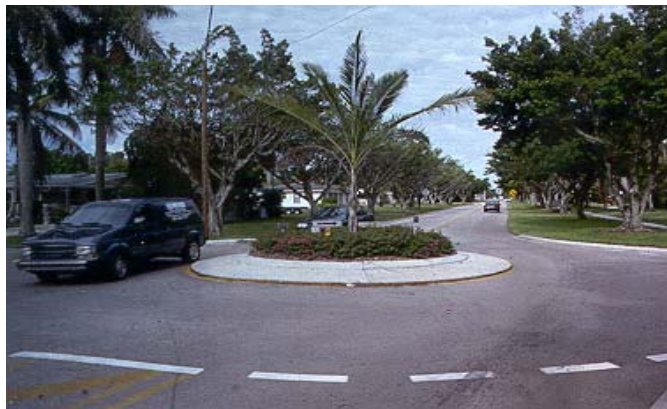
รูปที่ 6-3 วงกลมจราจรที่สามารถไต่ขึ้นไปได้
