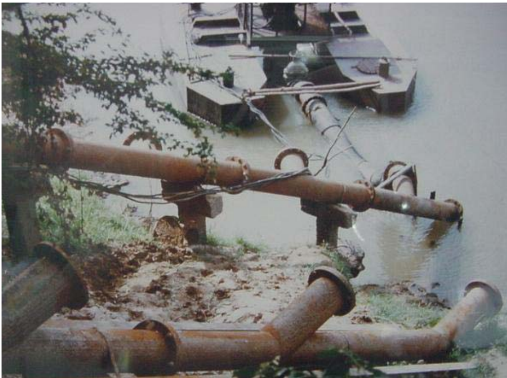
ภาพที่ 2.7 ลักษณะการติดตั้งเครื่องสูบน้ำบนแพ
